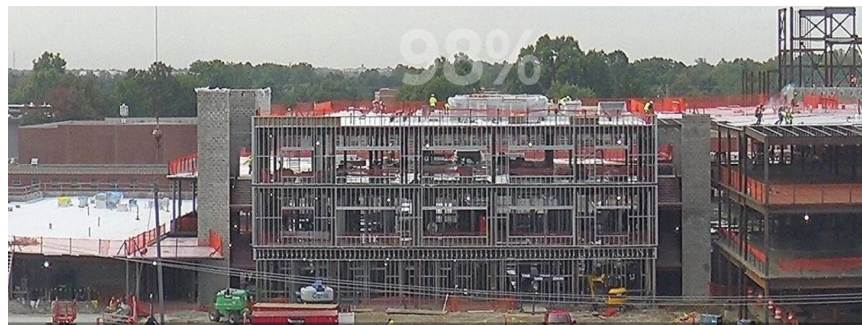
Marco exterior norte
