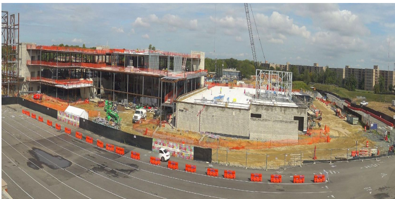
Trabajo de techado
