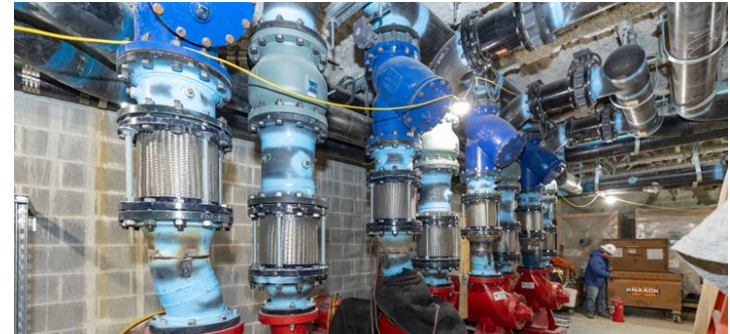
Instalación del equipo mecánico
