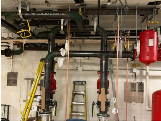
Estaciones de tuberías y bombas de distribución de calefacción/refrigeración hidráulica
