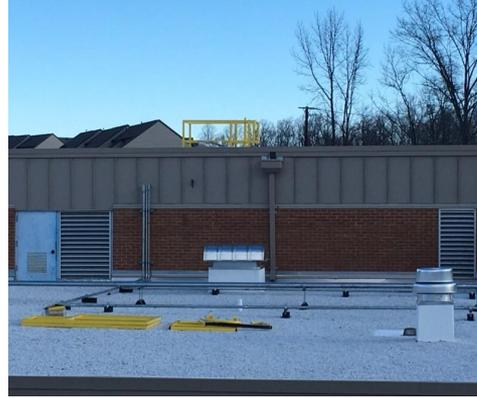
Ventiladores extractores de aire montados en el techo, rejillas de ventilación por gravedad y rieles de seguridad.
