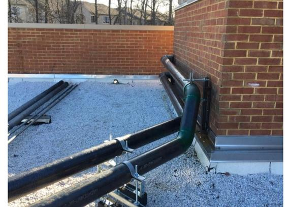
Tubería de distribución de enfriamiento hidráulica montada en el techo.
