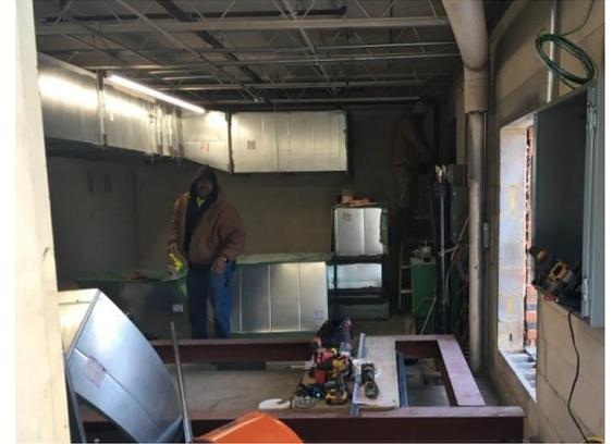
Enmarcado de acero estructural para equipos del ático.
