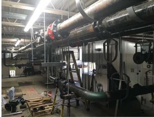
Unidades de manejo de aire y tuberías de distribución de calefacción/refrigeración hidráulica.
