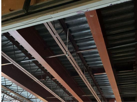
Soportes de acero estructural para equipos montados en el techo.
