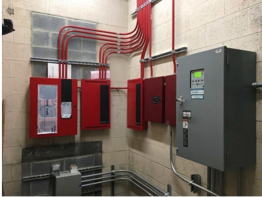
Panneaux de détection d'incendie numériques et adressables
