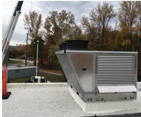
Système d'air extérieur de cuisine
