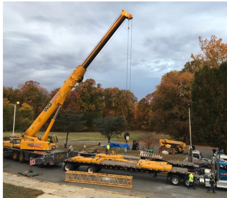
Livraison des unités de HVAC
