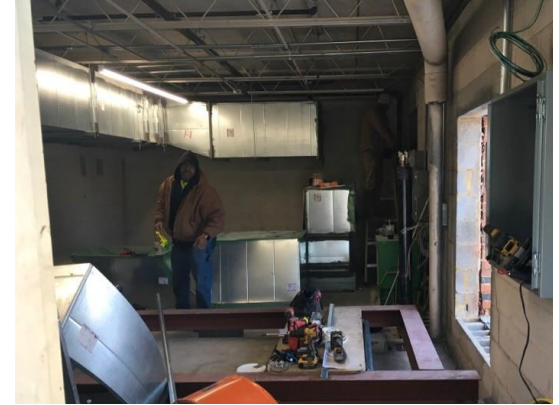
Structure en acier pour équipement du penthouse
