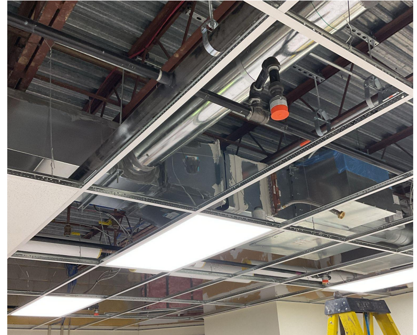
Unité terminale à volume d'air variable
