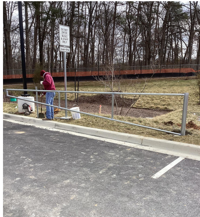
نصب و راه اندازی دروازه راه
